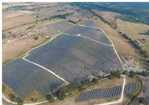
Molti impianti della società sono attivi tra Canino e Montalto di Castro
